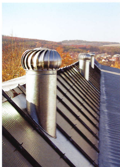
Turbíny LOMANCO na šikmé střeše výrobní haly
